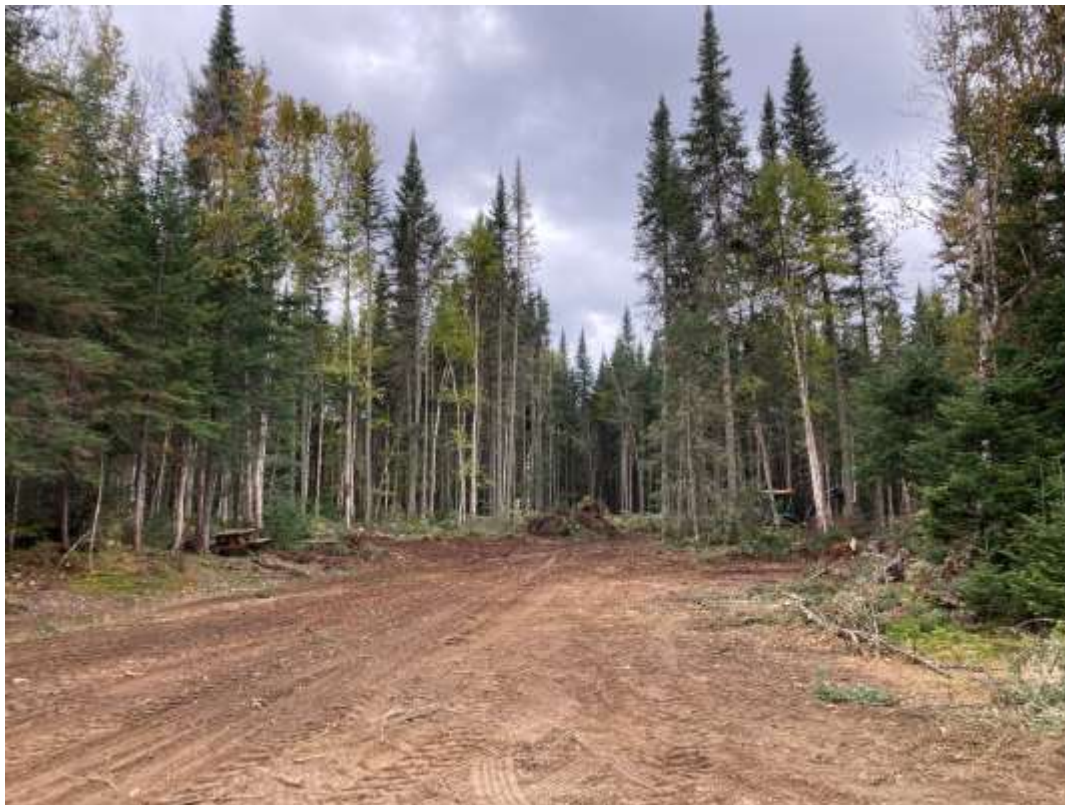
Figure 13 : Déboisement et nettoyage du site, vue du chemin, pendant l'aménagement, saison 2020.
