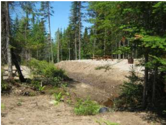
Figure 6 : Fossé de drainage du camping La Salle, avant l'aménagement.
