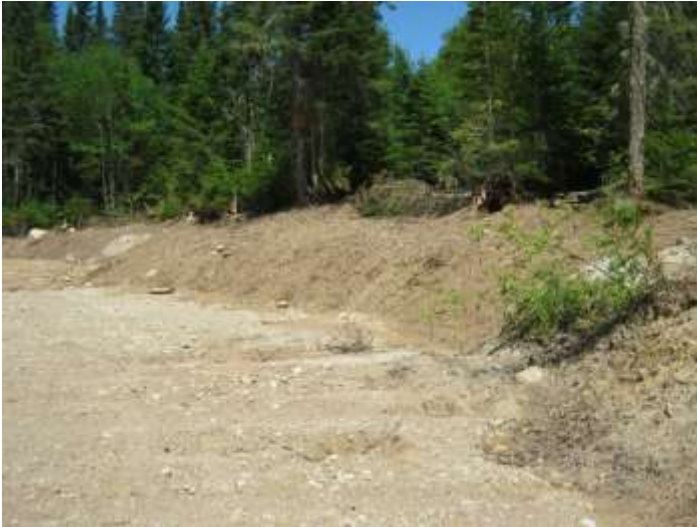
Figure 8 : Talus du camping La Salle, avant l'aménagement.
