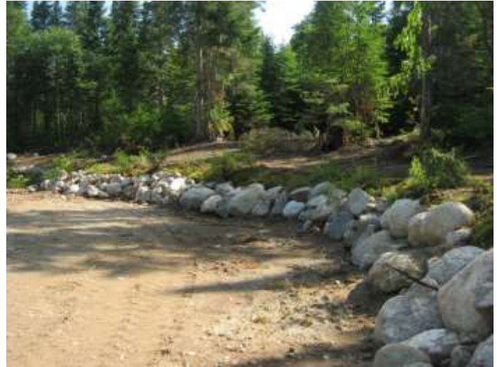
Figure 9 : Talus du camping La Salle, après l'aménagement.
