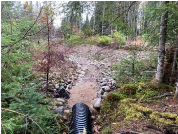
Figure 7 : Fossé de drainage du camping La Salle, après l'aménagement.
