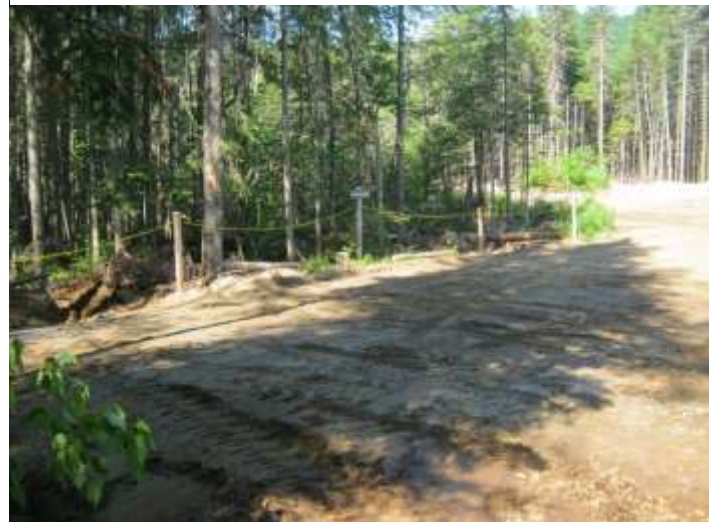
Figure 11 : Stationnement du camping La Salle, après l'aménagement.
